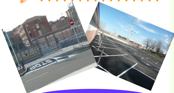
Entrada aparcamiento de la Avda. Segovia
